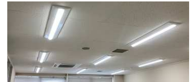
照明器具のLED更新
